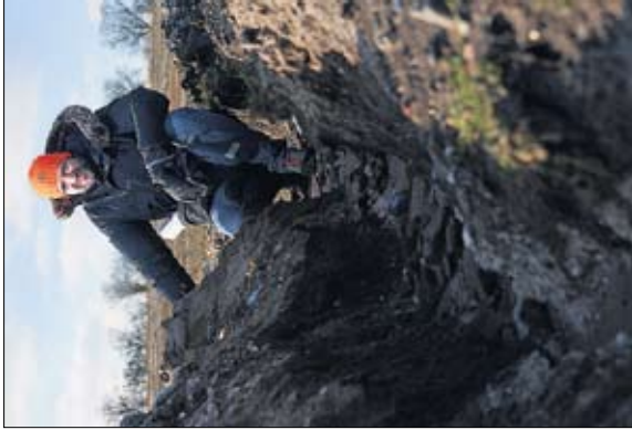
Sidste års kraftige nedbør "skar" dybe slugter i den blottede jord, hvilket gjorde en ekstra bortgravning af muld fra kalkundergrunden nødvendig. Foto: Henrik Bo
